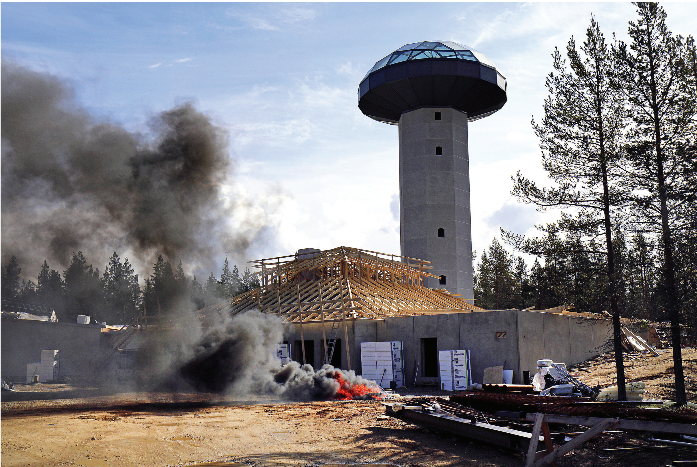
VIIME torstaina Kakslauttasan uuden tornitalon rakennustyömaalta nousi
